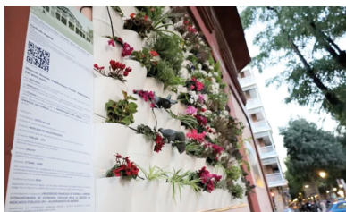
Ilustración 71. Prototipo de una envolvente biosolar en el Mercado de Vallehermoso (Madrid). (Fuente: OTRI UFV ).
