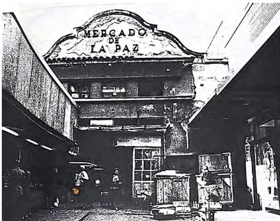
5.2. Entrada al Mercado de la Paz por calle Lagasca, previo a la intervención.
