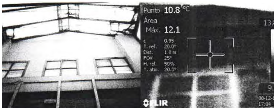
6.13. Termografía original del Estudio Energético de 2011.
