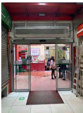
5.5. Cortinas de aire en el Mercado de la Paz en las puertas de acceso.
