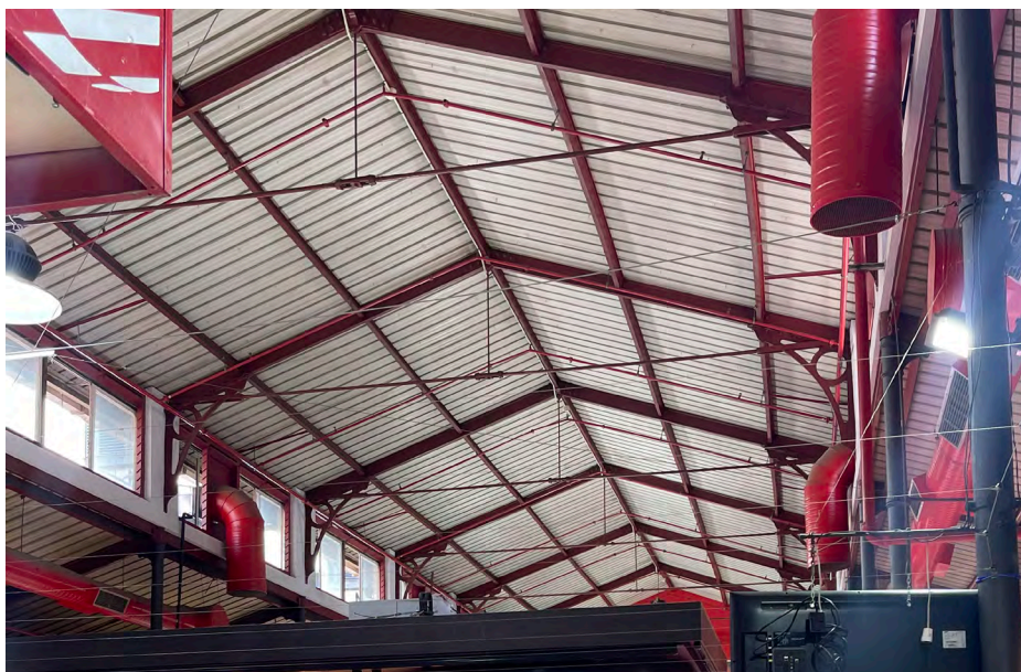
5.18. Imagen cubierta actual.
