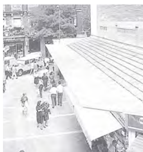
5.3. Puestos adosados, exterior del Mercado de la Paz, tras intervención.
